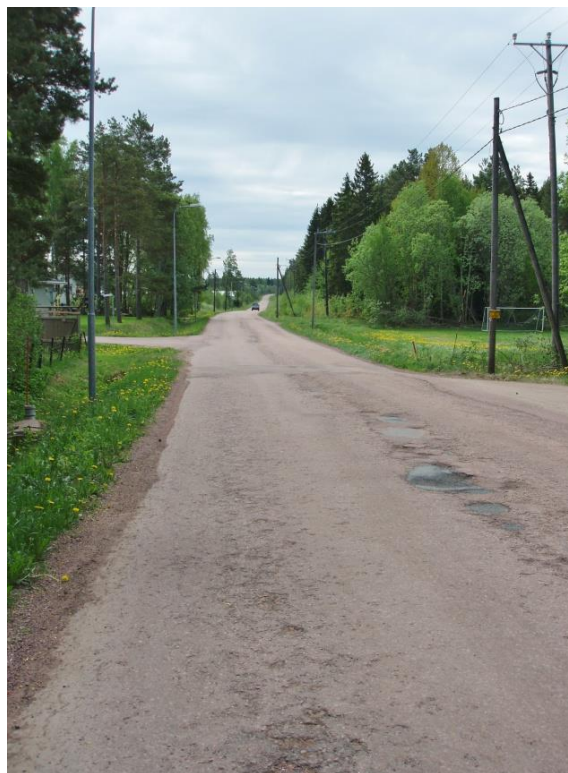
Foto 3: Kalmarnäs uppsamlingsväg som är i behov av ombyggnation (2012).
