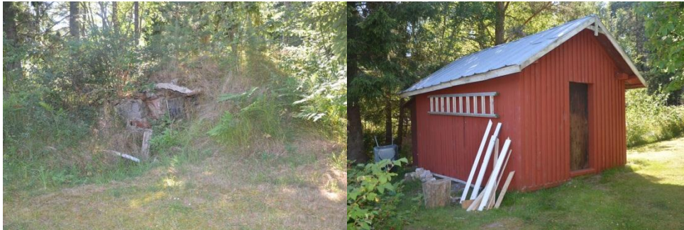
T.v. den kraftigt förfallna jordkällaren. T.h. sädesmagasinet.
