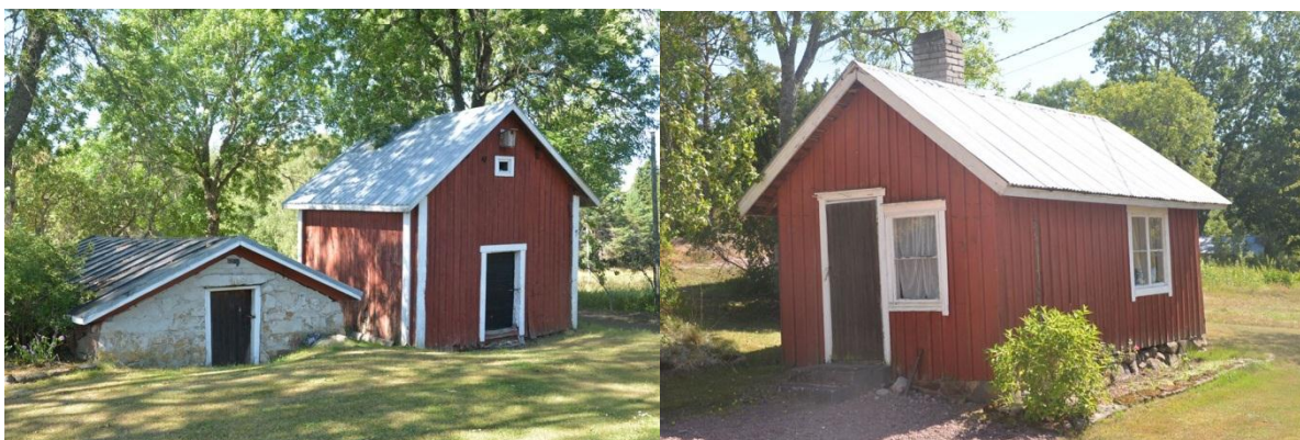
T.v. jordkällare och bod. T.h. uthus.
